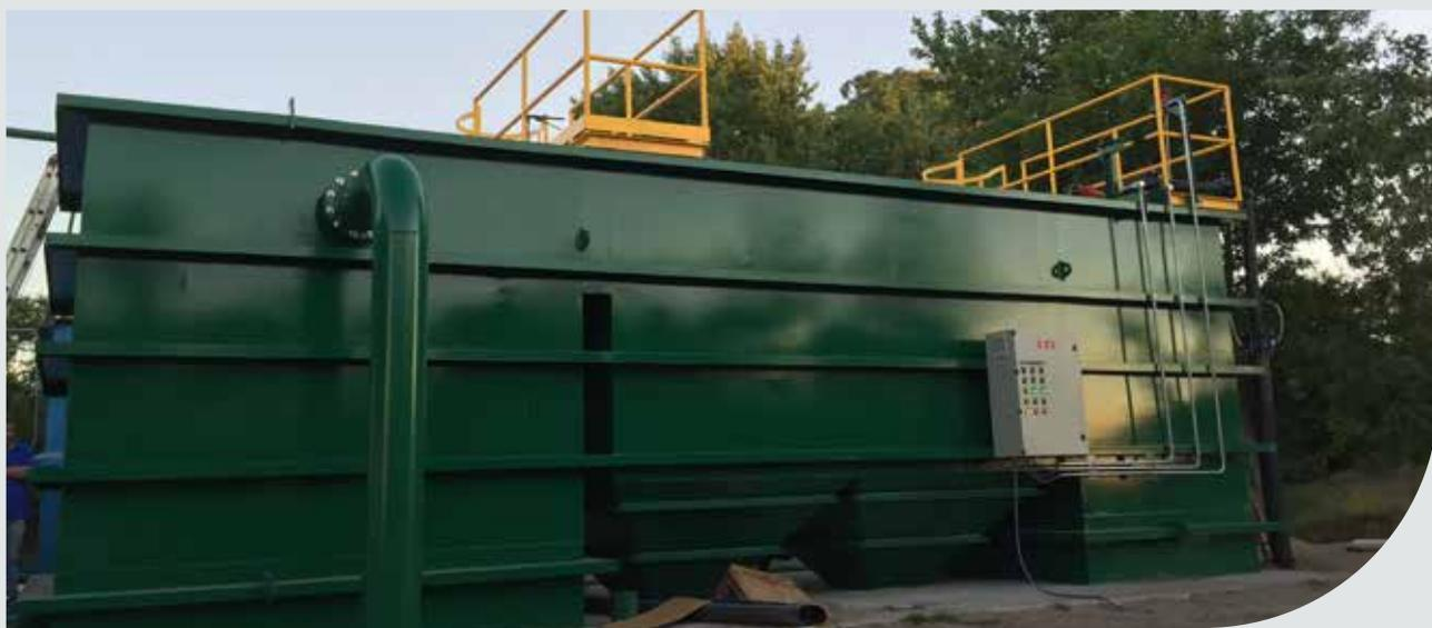
Para proyectos que requieren capacidades de tratamiento elevadas y baja disponibilidad de espacio, contamos con referencias en el diseño y suministro llave en mano de módulos con tecnología "Moving Bed BioReactor MBBR" y Membrane Biological Reactor "MBR"
